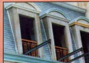
Arcos de portas e friso em acabamento e telhado pronto
