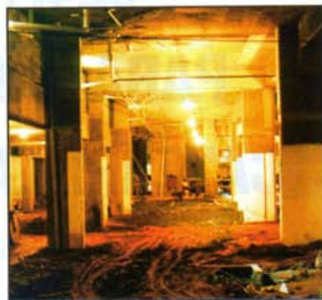
Subsolo, onde localiza-se a garagem, tem 11 000 m 2
